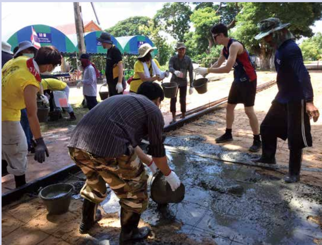
第15回タイ国青少年ワークキャンプ。道路のコンクリート舗装作業。(6頁参照) 撮影/阿部春代
